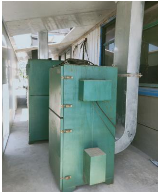
图 3-3 布袋除尘器 (PL-苏型系列除尘器 4000m 3 /h)
