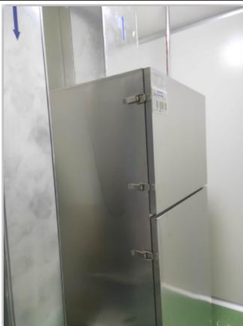
图 3-4 脉冲式滤筒不锈钢除尘器 (SB-Y08-021、900m 3 /h)
