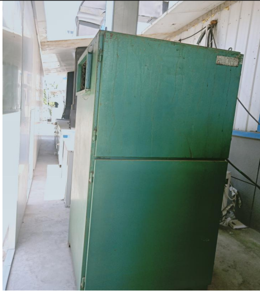
图 3-2 布袋除尘器 (PL-苏型系列除尘器 5000m 3 /h)
