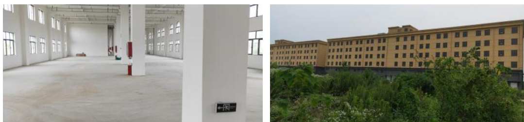
图 3-1 场地建设现状
